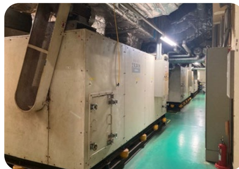
工程集約・空調機1台停止 年間約222,000kWh削減
