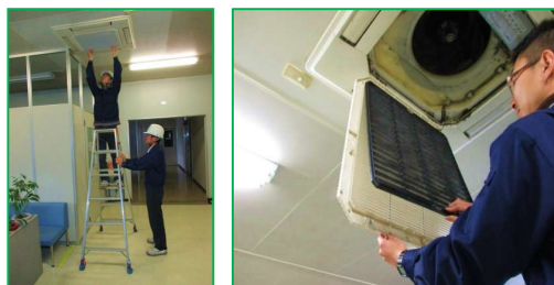
【点検作業の様子】
